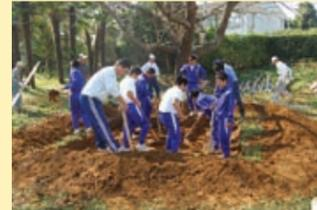
床が地表面より一段低くなるよう、3m四方の地面を掘り込み。
