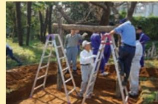
地面に柱穴をあけ、檜（ナラ）の柱と桁（ケタ）をセット。
