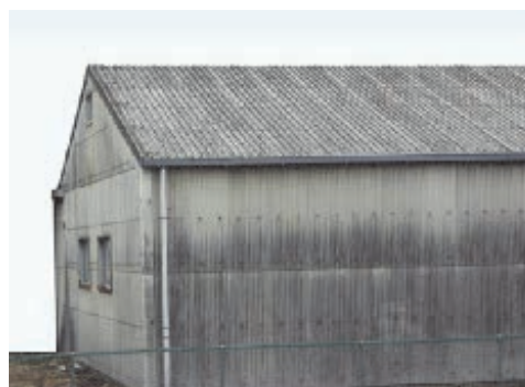
石綿含有スレート波板（屋根・外壁）
