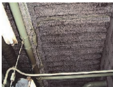
石綿含有吹付けロックウール
