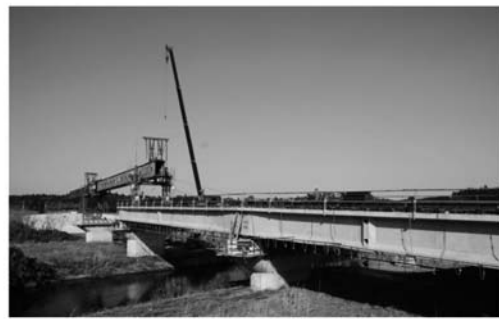
▲市道㊨55号線(粟田橋)建設工事
