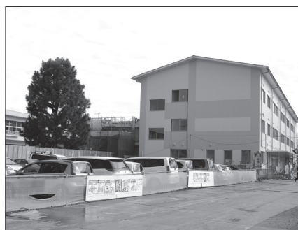
△耐震化と増築工事が進む下稻吉小学校
