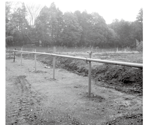
↑柵による侵入防止策
