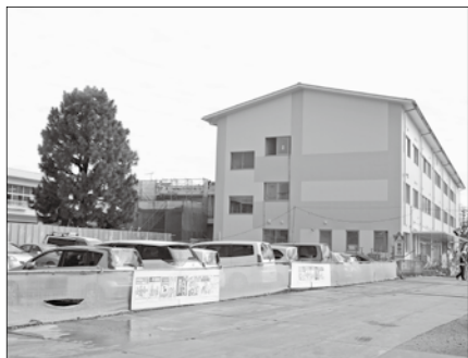
△耐震化と増築工事が進む下稲吉小学校
