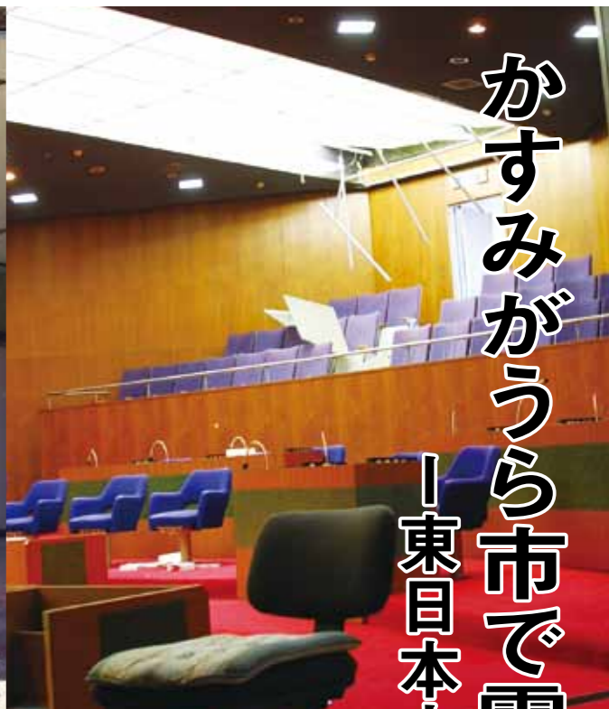
↑(左)講堂入口の一部が崩落した千代田公民館 (右)天井の一部が崩落した千代田庁舎3階講場
