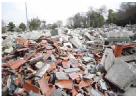
↑旧霞ヶ浦庁舎ストックヤードには、倒壊した塀や根瓦などが集まりました。
