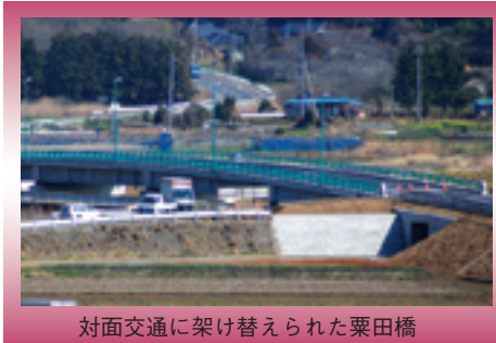
対面交通に架け替えられた粟田橋
