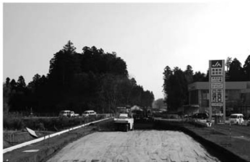
▲市道㊦2644号線(深谷大和田バイパス)建設工事
