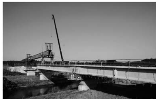
▲市道㊨55号線(粟田橋)建設工事
