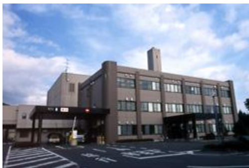
図 3-2 クリーンセンター施設外観
