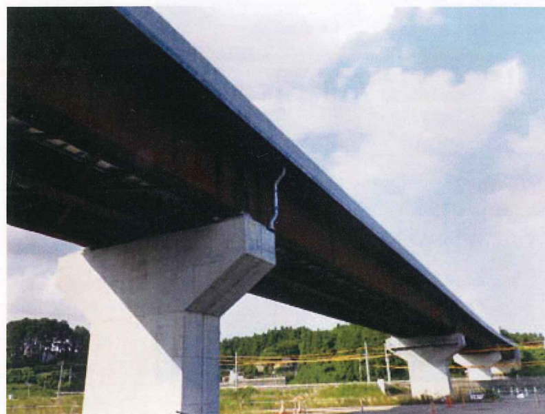
▲東田中高架橋(上部工完成)
