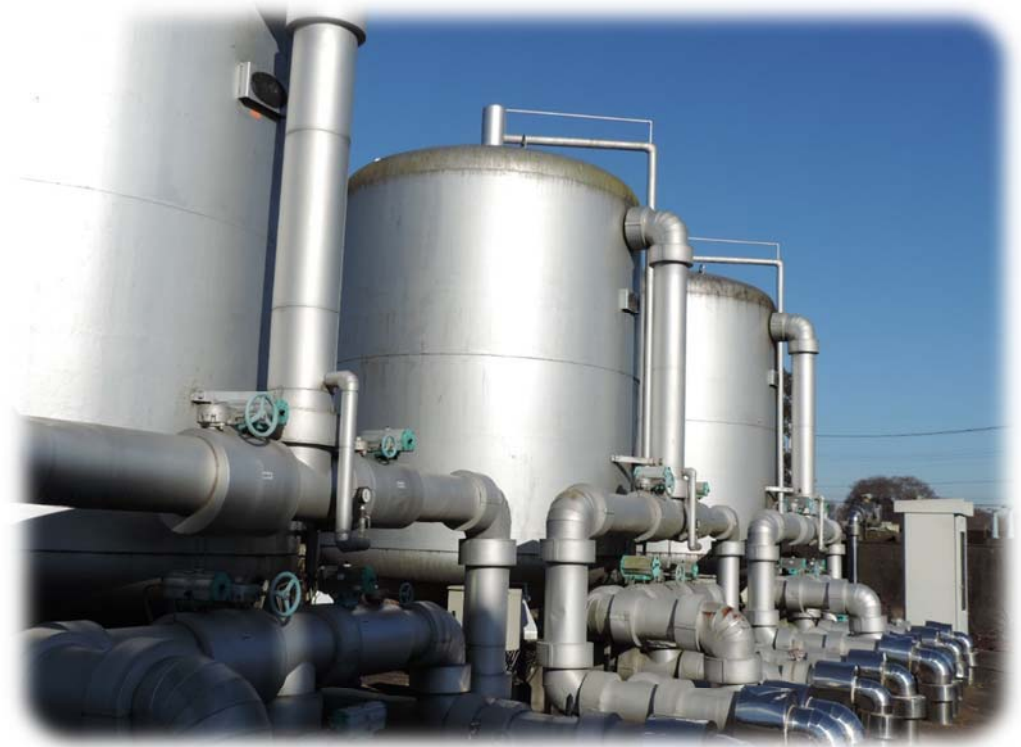
— 霞ヶ浦浄水場 急速ろ過器 — (霞ヶ浦地区)
