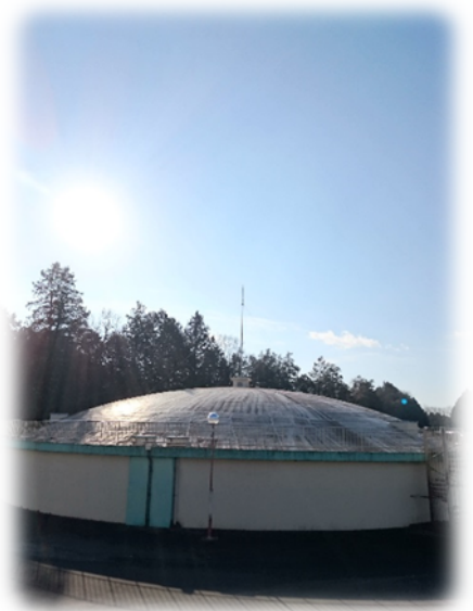
— 霞ヶ浦浄水場 県中央用水受水配水池 — (霞ヶ浦地区)
