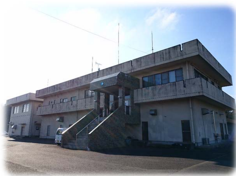
— かすみがうら市水道事務所 : 霞ヶ浦浄水場内 —
