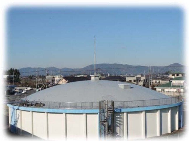
－ 下稲吉第2浄水場 県西用水受水第3配水池 (千代田地区) －
