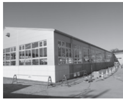
▲改築中のプール
