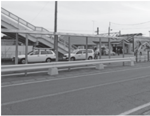
▲工事中のJR神立駅
