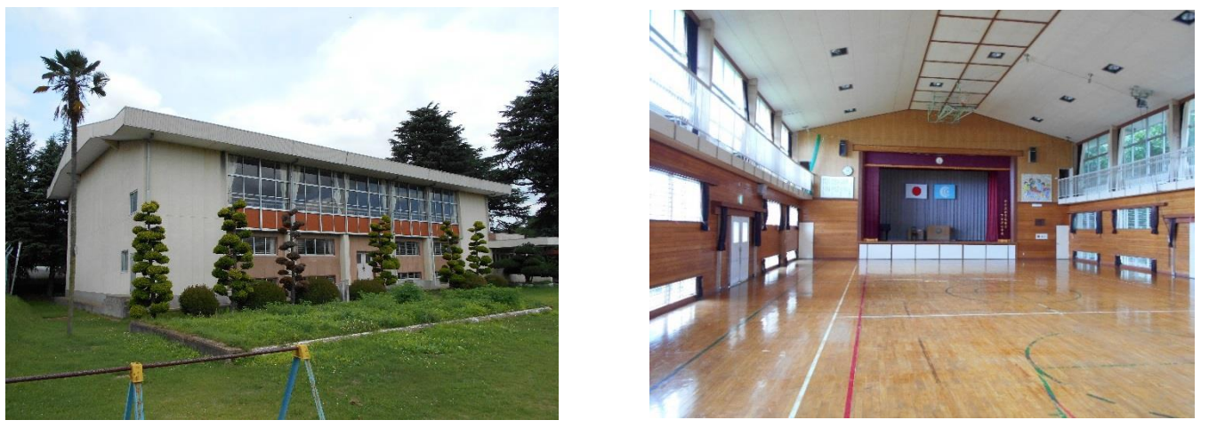
屋内運動場(体育館) 外観・内観
