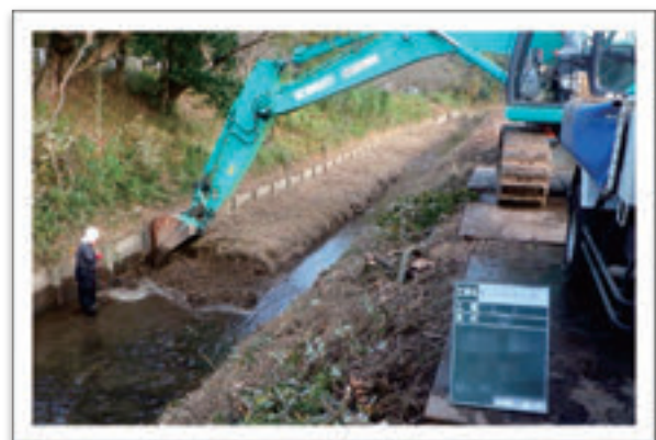
〔浚渫工事（雪入川）〕
