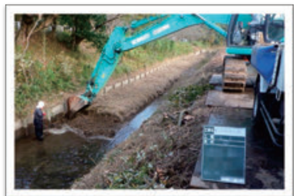
〔浚渫工事（雪入川）〕
