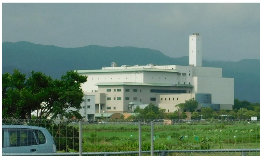
(1日300tもの処理能力を持つ佐賀市清掃工場)
