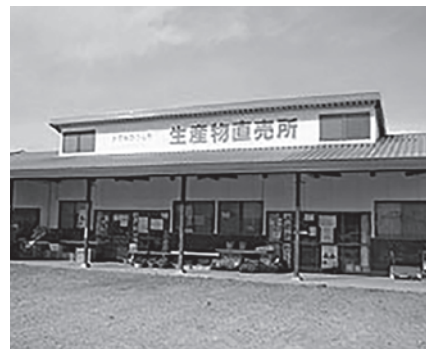
▲かすみがうら市活性化センター 生産物直売所
