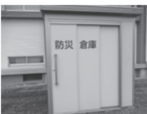
▲防災倉庫 (北小学校)
