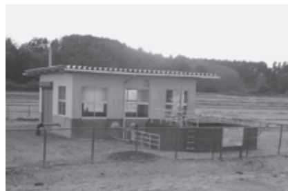
▲排水機場（安食地内）
