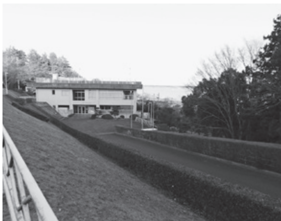
▲土砂災害特別警戒区域指定解除となった農村環境改善センター斜面
