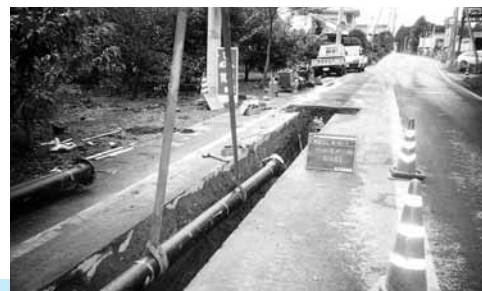
▲旧霞ヶ浦町水道管布設
