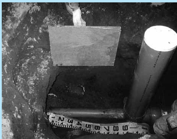
▲公共汚水枅設置状況
