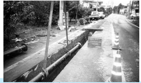
▲旧霞ヶ浦町水道管布設
