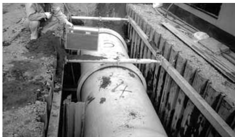
▲旧千代田町雨水管布設
