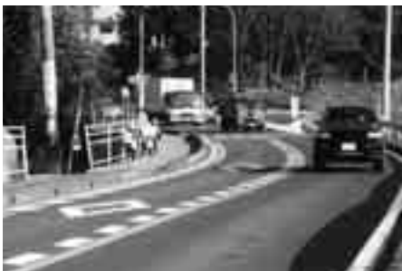
▲国道354号 霞ヶ浦庁舎下付近
