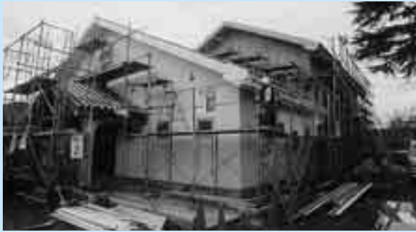
▲建設中の第3児童館
