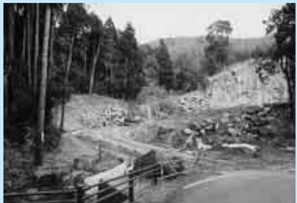
▲工事中の林道 三ツ石線
