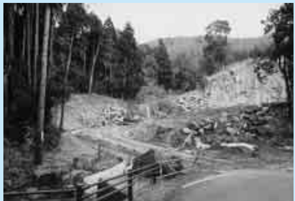
▲工事中の林道 三ツ石線
