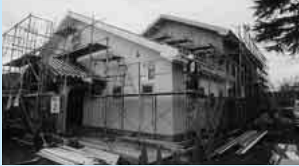
▲建設中の第3児童館
