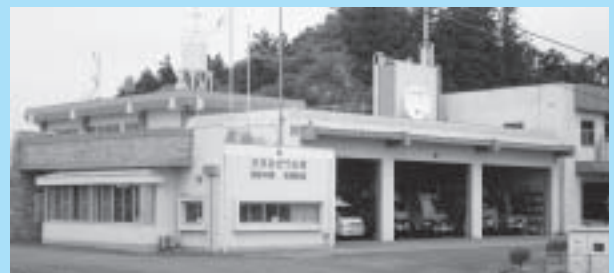
▲かすみがうら市消防本部・西消防署
