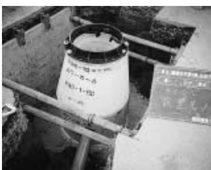
▲下水道マンホール設置
