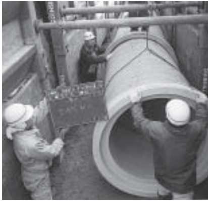
▲雨水管渠布設工事
