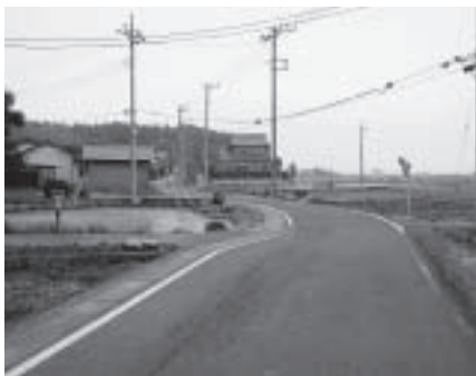
▲県道石岡・田伏・土浦線
