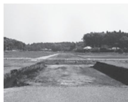
▲国道354号線バイパス整備事業
