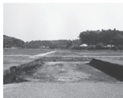
▲国道354号線バイパス整備事業
