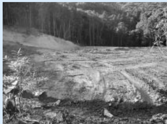
▲加賀山埋め立て状況
