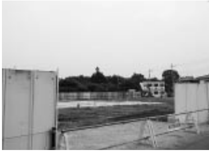
▲(仮称)かすみがうら市地域福祉センター建設用地
