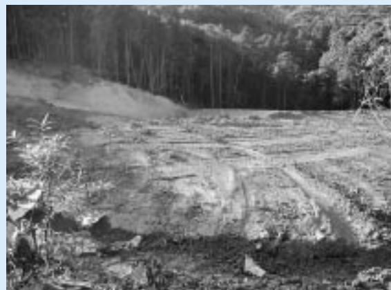
▲加賀山埋め立て状況
