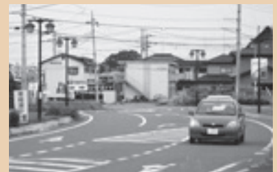
▲整備途中の神立停車場線
