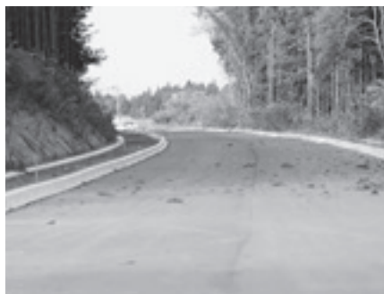
▲大和田バイパス整備状況
