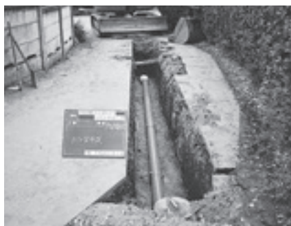
▲下水道管の埋設工事
