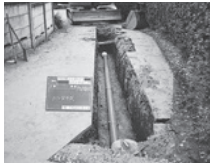
▲下水道管の埋設工事
