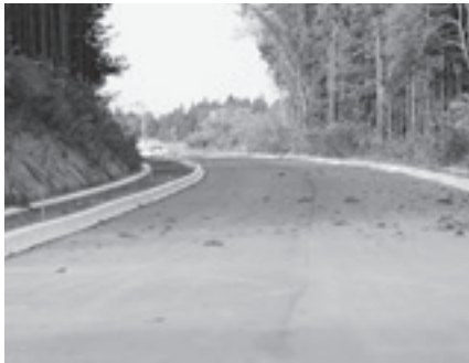
▲大和田バイパス整備状況
