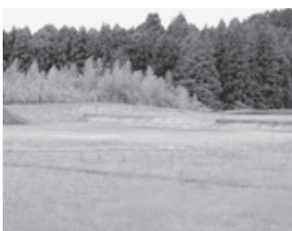
▲造成が完了した志筑小学校建設予定地
