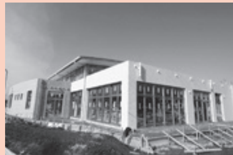
▲完成間近の（仮称）かすみがうら市福祉センター
