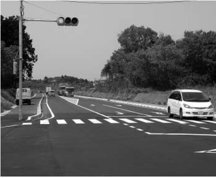
▲開通した市道の2644号線 (深谷大和田バイパス)
