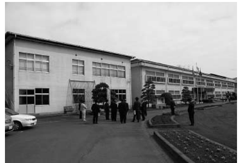
▲安飾小学校校舎の現地調査
