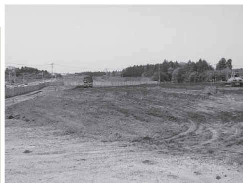
▲霞ヶ浦庁舎建設地
