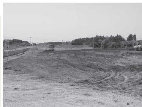
▲霞ヶ浦庁舎建設地
