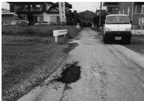
▲市道の路面補修
