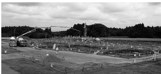
◀霞ヶ浦庁舎建設現場
