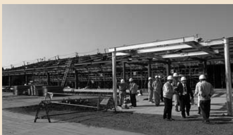
▲霞ヶ浦庁舎建設現地調査
