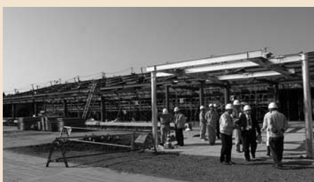
▲霞ヶ浦庁舎建設現地調査
