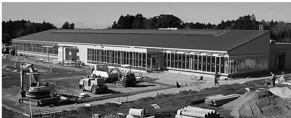
▲完成間近の霞ヶ浦庁舎
