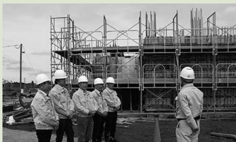
▲志筑小学校新築校舎の現地調査
