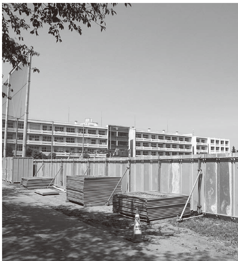
下稲吉中学校校舎耐震補強工事
