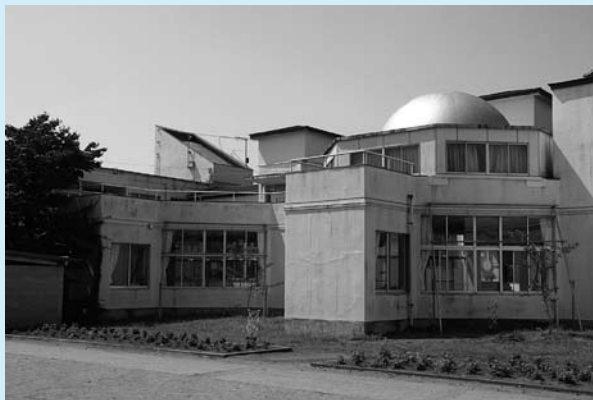
▲中央校舎外観
