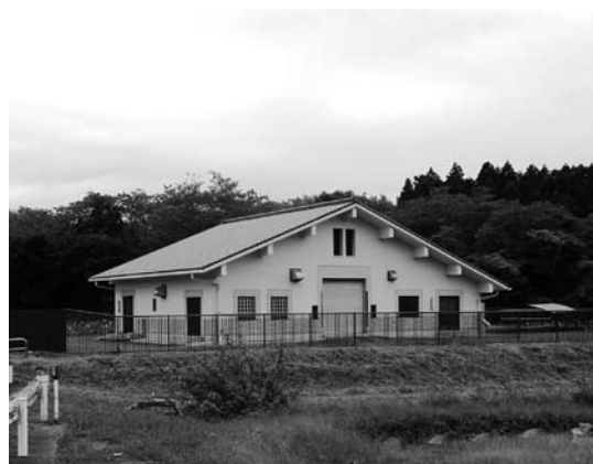
▲農業集落排水処理施設
