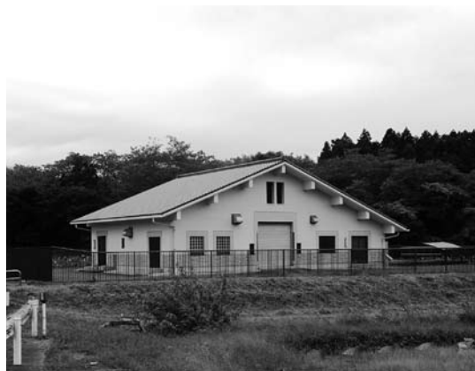
▲農業集落排水処理施設
