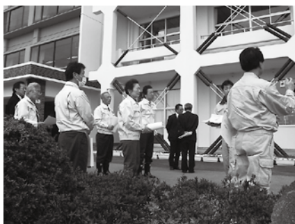
▲下稲吉中学校校舎耐震補強工事の竣工状況の確認
