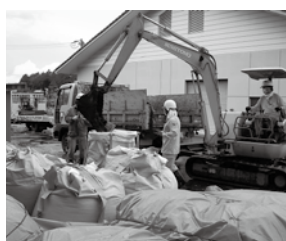
▲脱水汚泥の仮置き状況
